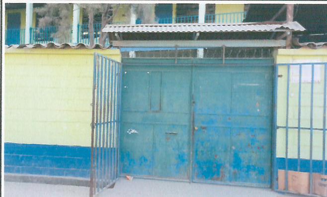
Foto 2: Remodelación de Muro Perimetral
